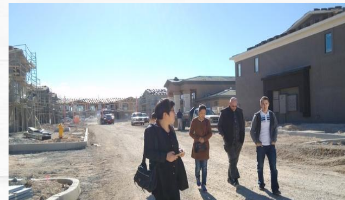
USA villa-cluster project
